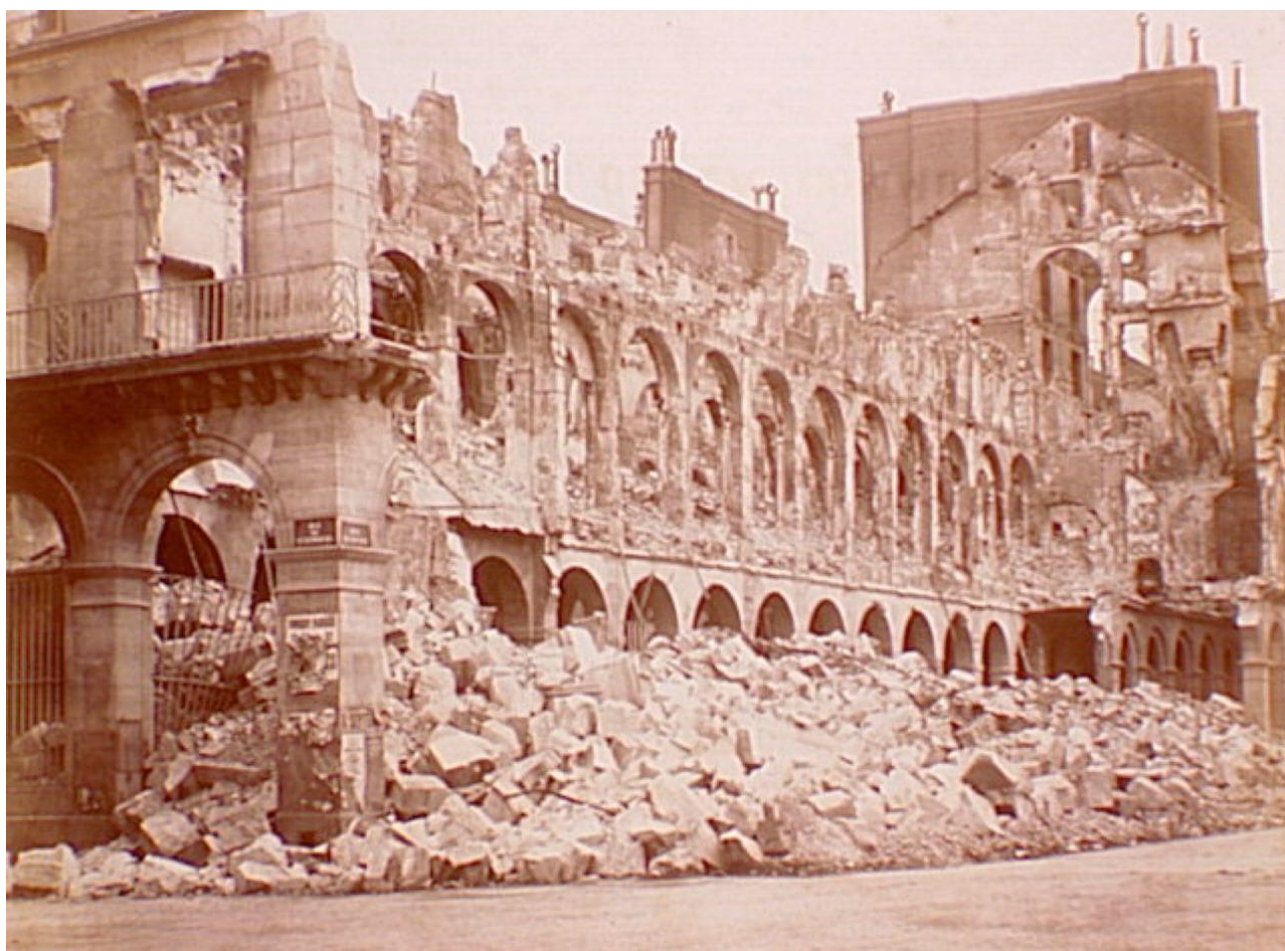
L'edificio del Ministero delle finanze francese dopo i bombardamenti. Parigi, 1871
